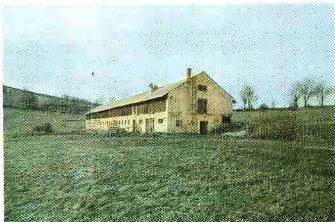
Kravín v Pelkovicích (postaven v roce 1949)
